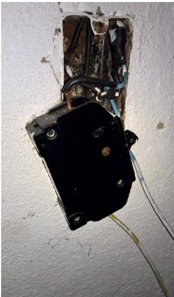
Disjuntores sem fixação, com partes vivas expostas e usadas como seccionamento de circuitos de uso livre.
