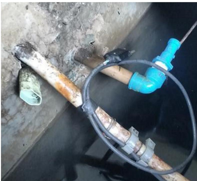
Bomba para abastecimento da CMVR ligada diretamente em tomada sem nenhum tipo de resistência a água, localizada em local de afluência de público.
