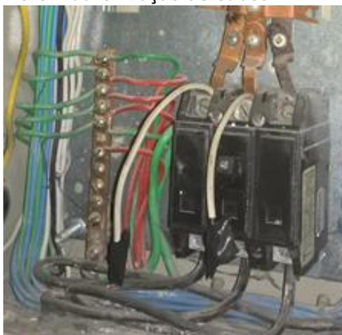
Cabos de cor divergente da padronização sendo usadas como condutor PEN.
