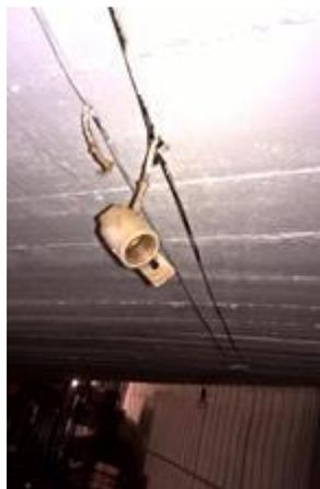
Local usado como almoxarifado de arquivos de documentos, com cabeamentos expostos, acesso limitado, emendas deterioradas e iluminação incandescente.
